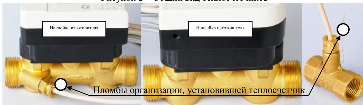
Рисунок 2 – Схема пломбировки теплосчетчиков
